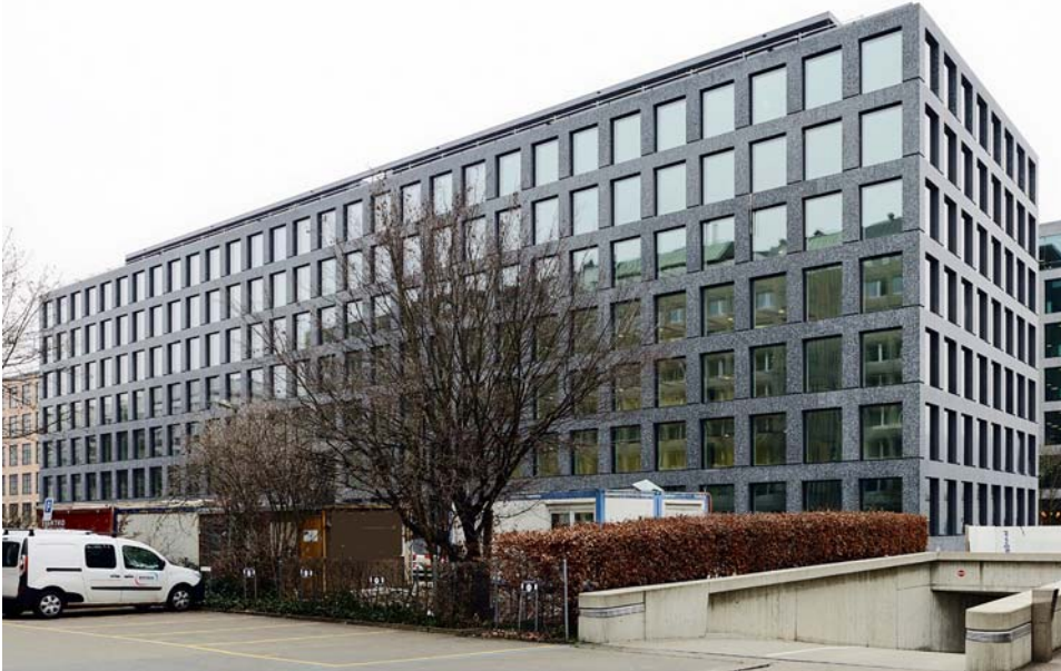
Das neue Bürogebäude an der Herostrasse 12 in Zürich-Altstetten. (Bilder: Allreal)
